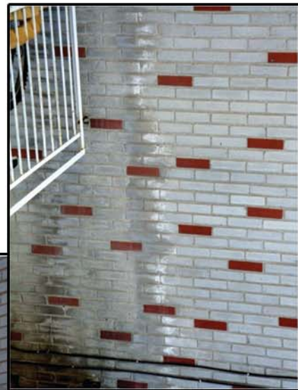
Taches causées par des infiltrations d'eau
