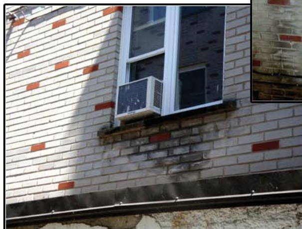
Taches causées par des infiltrations d'eau
